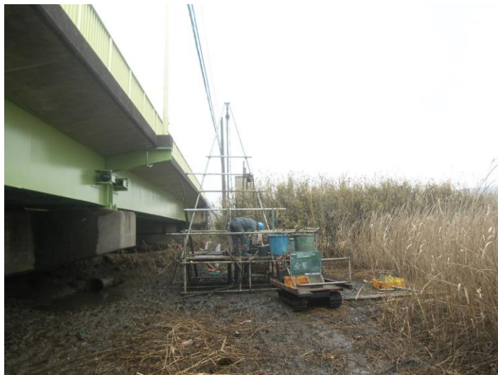
湿地での調査例（かさ上げによる平坦地足場）
